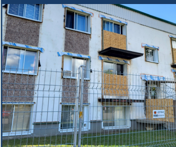
Pendant les travaux
