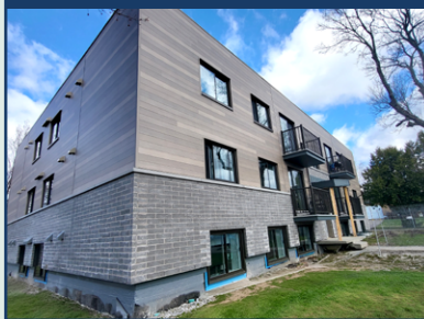
Après les travaux
