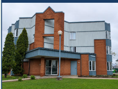
Après les travaux
