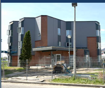
Pendant les travaux
